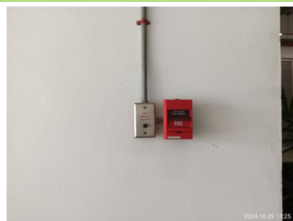
รูปที่ 3-48 อุปกรณ์แจ้งเหตุเพลิงไหม้แบบมือกด
