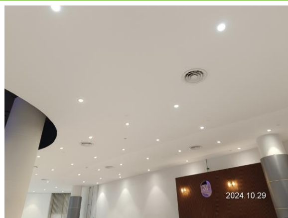
รูปที่ 3-46 หลอดไฟ LED แบบประหยัดพลังงาน
