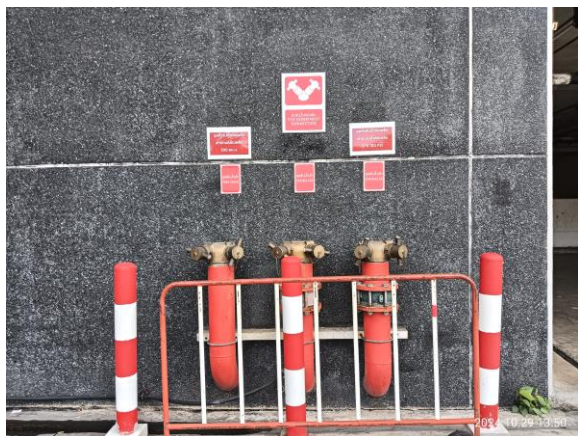
รูปที่ 3-56 หักรับน้ำดับเพลิงภายนอกอาคาร
