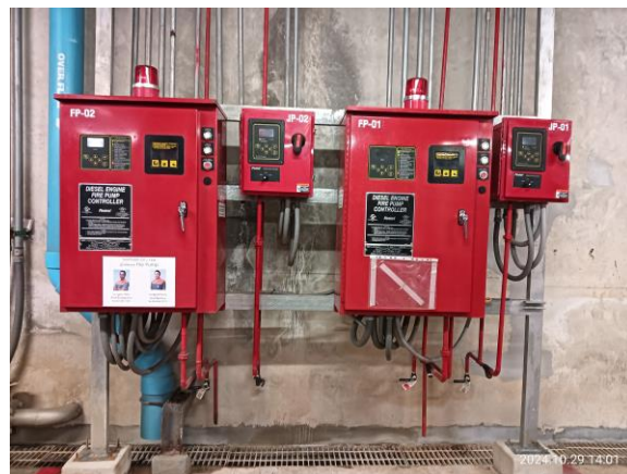
รูปที่ 3-57 ระบบปั๊มดับเพลิงอัตโนมัติ
