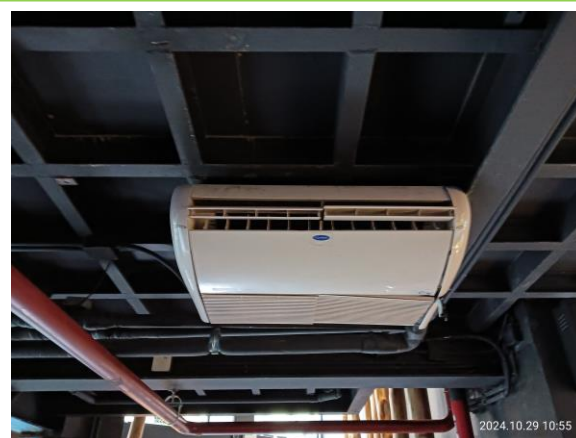
รูปที่ 3-67 เครื่องปรับอากาศ Fan Coil Unit (FCU)
