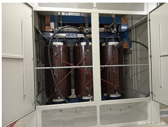
รูปที่ 3-41 ติดตั้งหม้อแปลงไฟฟ้าชนิดแห้ง (Dry Type Transformers)
