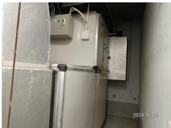
รูปที่ 3-65 Air Handling Unit (AHU)
